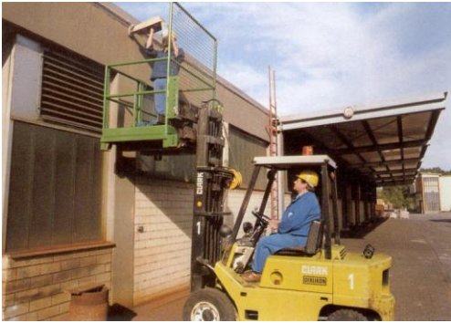
Pav. 41. Darbo platforma su apsauga nuo nukritimo
