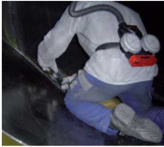
pav. 7-1. Filtruojantis prietaisas su akumuliatoriniu kompresoriumi
