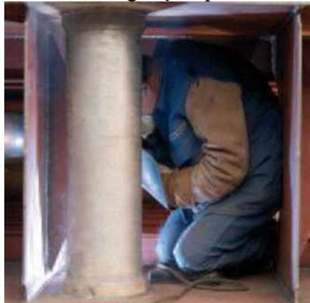
pav. 6-4. Suvirintojas elektros lanku dirba padidinto elektros poveikio pavojaus sąlygomis. Suvirintojas apsaugotas izoliuojančiu kilimėliu
