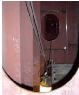
Pav. 1-2. Laivo šoninė talpa
