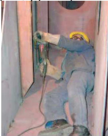
pav. 6-1. Elektros poveikio pavojus, 1 pavyzdys
