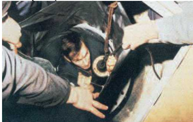
Pav. 2-1. Įmontavimas nuotėkio apsaugos (vidinės) 7000 l cisternoje
